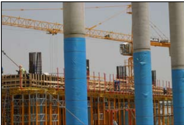
استفاده از قالب‌های مدولار برای اجرای سقف
