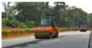
Route d'accès du Suc à Bizam
