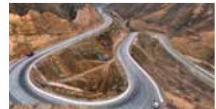
Reconstruction et élargissement de la route Bishkek-Osh
