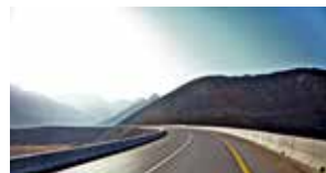
Construction de la route de Khassab à Al-Khalidiyeh
