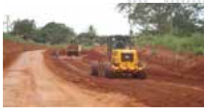
Construction de la route Sangmelima à Makouk- Bikoula
