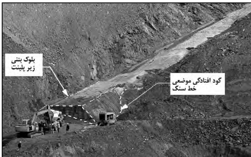
شکل ۱۱- نمایی از بلوک زیر پلینت درزها
