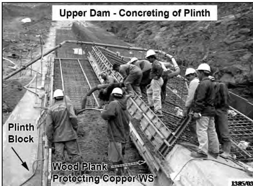
شکل ۱۰ - نمایی از اجرای Plinth سد بالای پروژه سیاه بیشه
