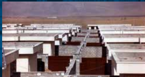
مجموعه مسکونی ۴۰۰ واحدی دورود
