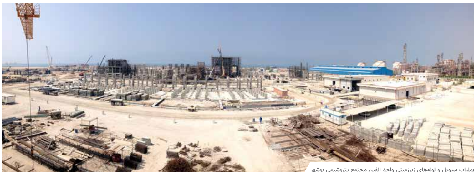
عملیات سیویل و لوله‌های زیرزمینی واحد الفین مجتمع پتروشیمی بوشهر
